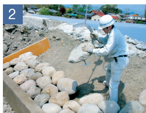
専用吊具使用・据付け状況
