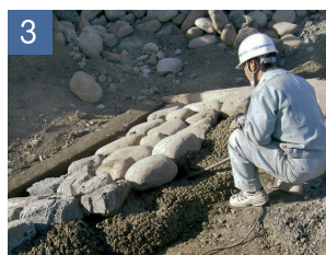
コンクリート打設(3列)
