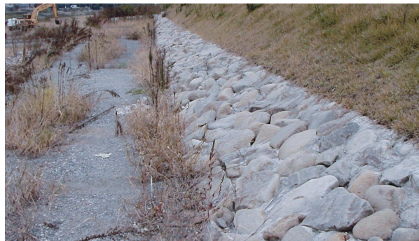
徳島県 通常砂防工事
