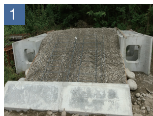
鉄筋架台設置完了
