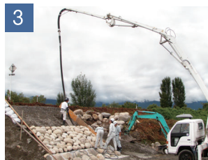
コンクリート打設
