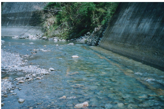
静岡県 朝比奈川 4層建型(連続沈床)
