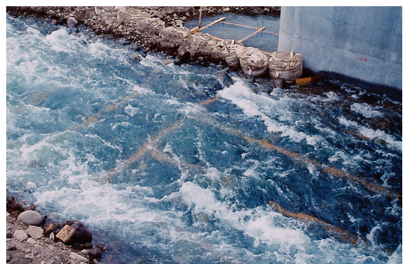
長野県 依田川 3層建型(連続沈床)
