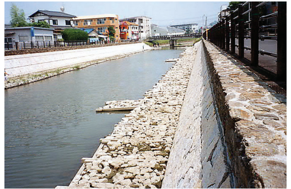
福岡県 金屑川 4層建型(連続沈床)
