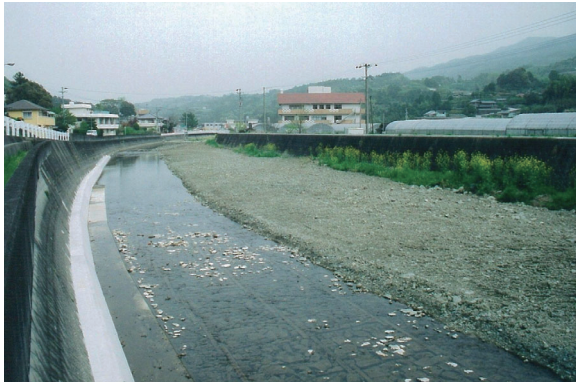
徳島県 園瀬川 4層建型(連続沈床)
