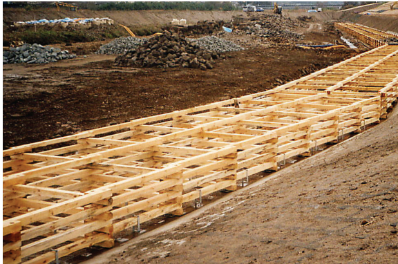
国土交通省 小鴨川 4層建型(連続沈床)
