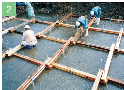
1層目設置・金具取付
