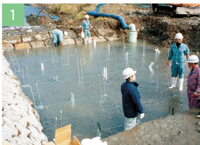
金網・連結金具設置
