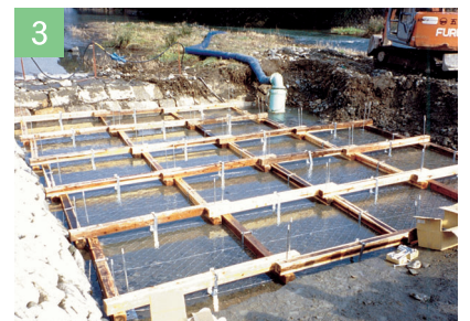
1層目設置完了
