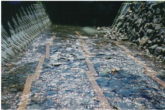
高知県 為ノ川 3層建型(単独沈床)
