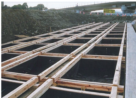
型枠組立・設置状況
