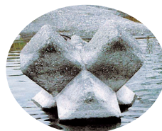
◀既設の護床ブロック
