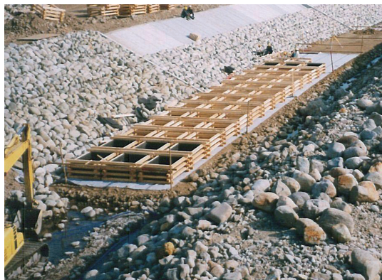
型枠組立・設置状況
