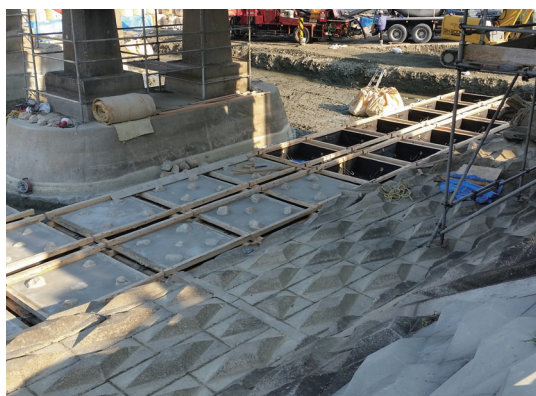
型枠組立・設置状況
