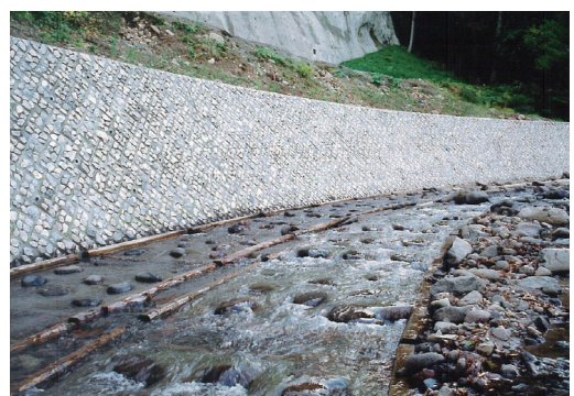
群馬県 蟻川 4t植石タイプ（災害復旧）
