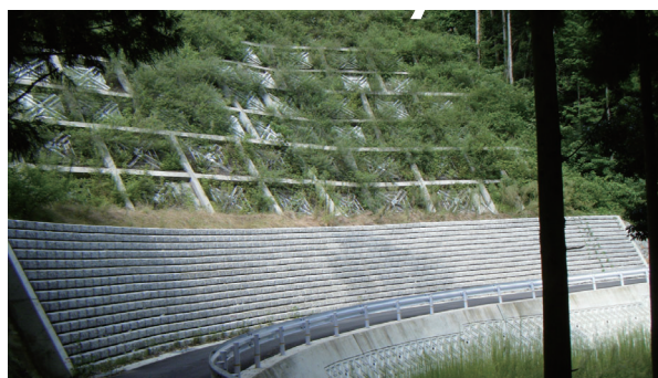
徳島県 阿野地区地すべり対策工事
