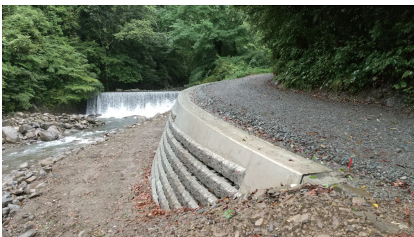
加江田林道災害復旧工事 (宮崎県)
