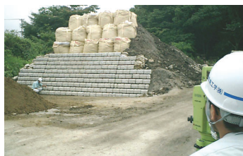
高盛土載荷試験 (変位測定状況)
