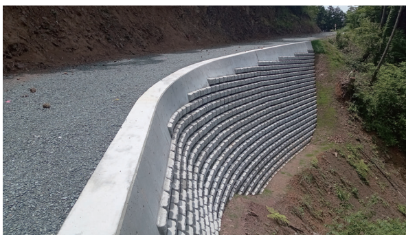
茂田井林道災害復旧工事 (熊本県)
