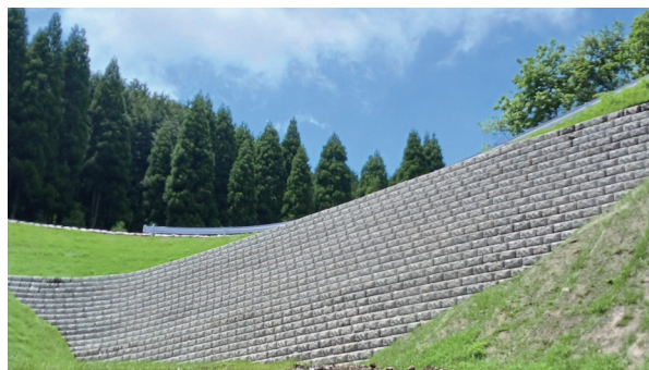
熊本県 松尾線林道災害復旧工事
