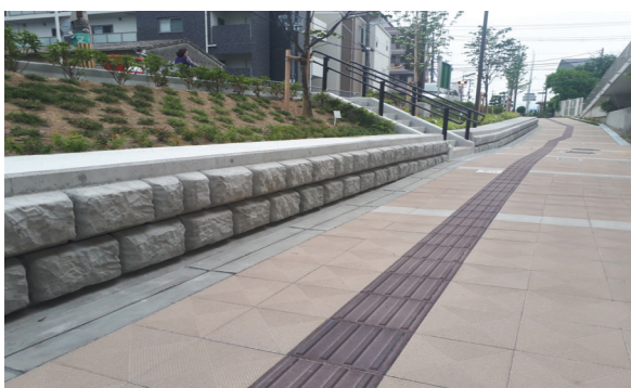
大阪府 服部天神駅 利倉東線歩道改良
