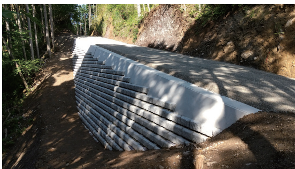
柿ノ谷2064災害復旧工事 (大分県)
