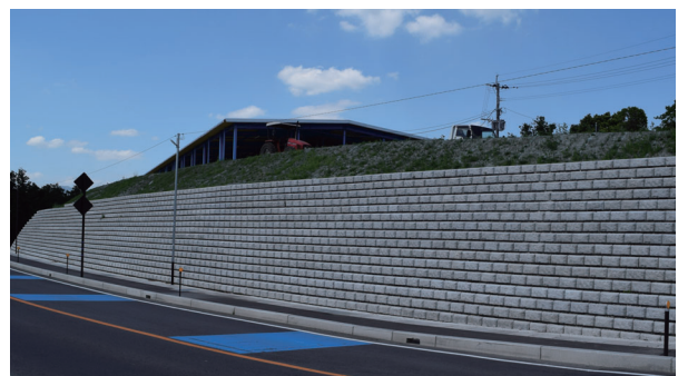
国土交通省 熊本阿蘇道路災害復旧(熊本県)
