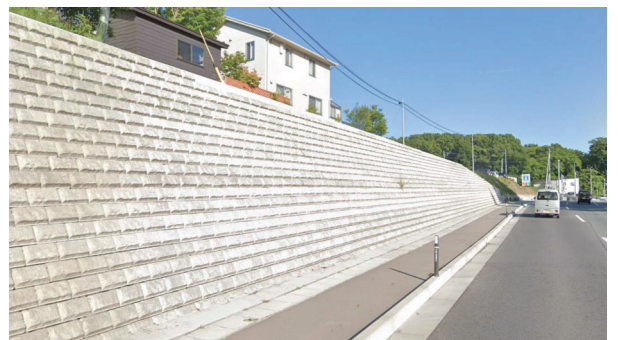
国土交通省 国道4号 崎山地区(岩手県)
