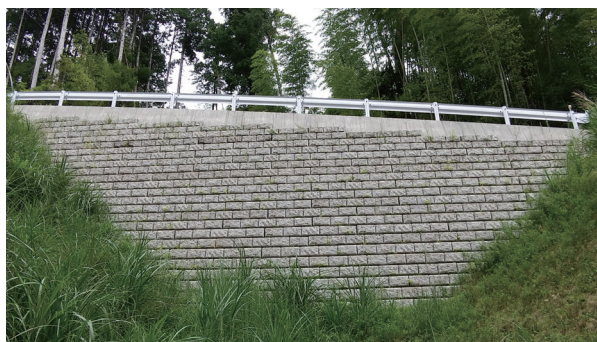
新山林道災害復旧工事 (福岡県)
