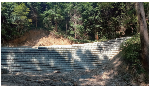
丸山林道災害復旧工事 (佐賀県)
