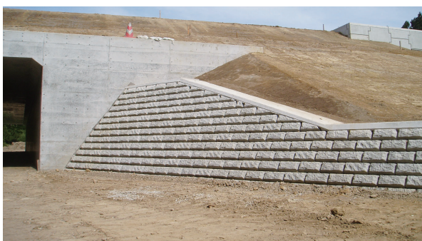
国土交通省 国道4号バイパス七戸地区(青森県)
