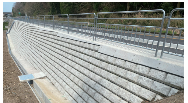
国土交通省 国道27号 若狭地区(福岡県)
