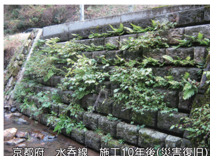
京都府 水呑線 施工10年後(災害復旧)
