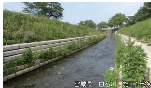
宮城県 白石川 施工1年後
