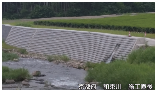
京都府 和束川 施工直後
