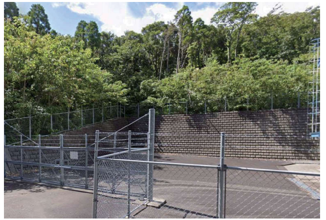
鹿児島県 一ノ谷発電所 施工後7年
