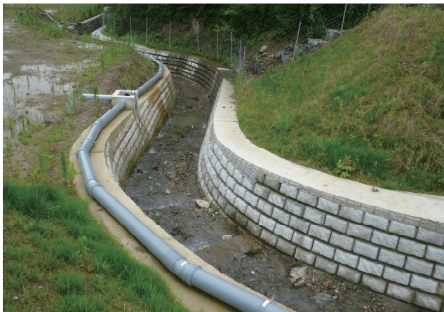
兵庫県 R477号災害復旧
