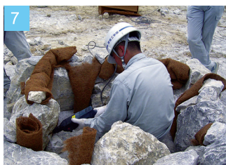
石材に削孔します。
