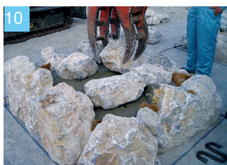
天端石を植石し養生。その後、間詰材を撤去します。
