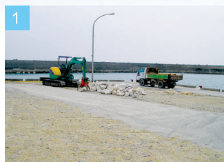
敷砂で製作ヤードを整地します。
