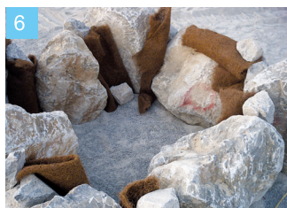
石材間に、間詰用割栗石とシートを用いて養生を実施します。
