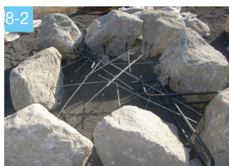
連結筋が必要な場合、アンカー部材と同時にセッティングします。
