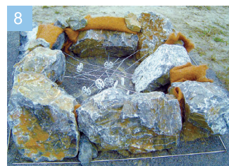
削孔した部分に、接着材で専用アンカー部材を取り付けます。
