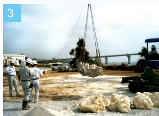
石材質量と凹凸を見ながら、所定の石材を選別します。
