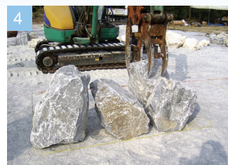
墨だし位置を参考に外周に石材を設置します。
