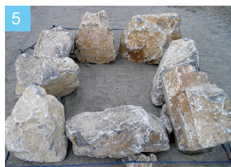
外周石8個設置状況。
