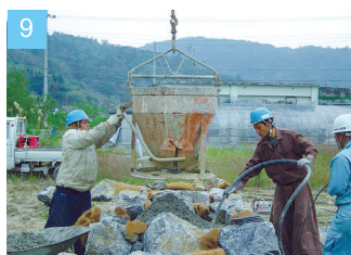
所定の容量の生コンクリートを投入し、打設します。
