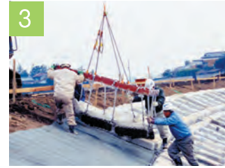
ブロックネット敷設
