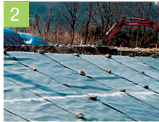
吸出し防止材または遮水シート敷設
